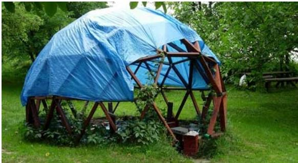
Геодезичен купол с диаметър 3м. и вертикална стена за основа на купола с височина 0.60м. и ширина 0.25м., изградена от тухли от непечена глина.Добавянето на стената дава възможност за по – рационално използване на вътрешния обем при този не голям радиус и добиване на по – голяма височина.
